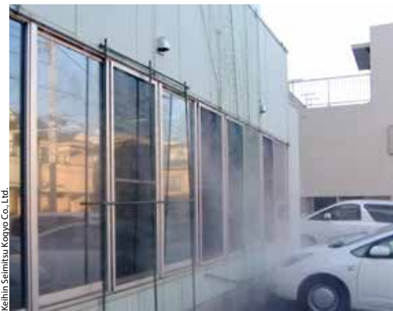
▲ „Mist Shower“: Die künstliche Gebäude-Dusche ist eine Eigenanfertigung und Ausdruck der spezifischen kaizen -Kultur bei KSK.
